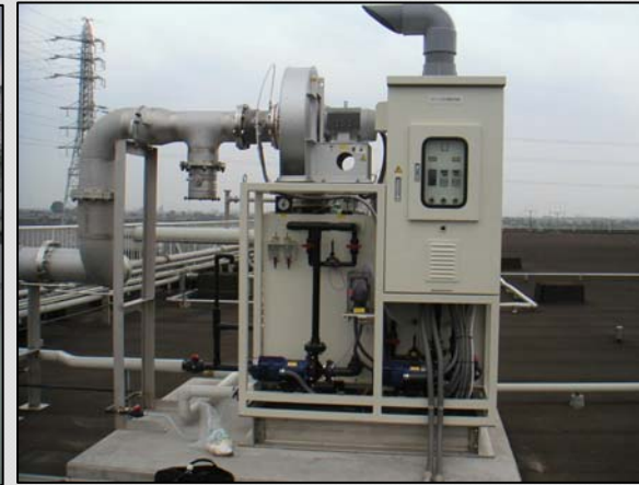
標準タイプ(1:1) 処理風量:20m 3 /min 用途:CVD装置
