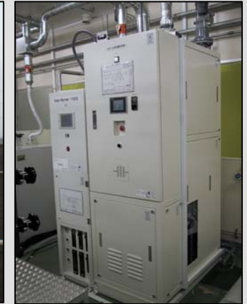
CR内設置タイプ(1:1) 処理風量:4.5m 3 /min 用途:研究開発
