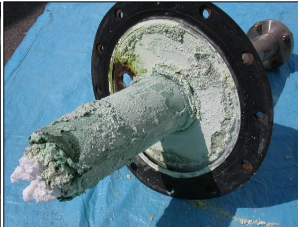
排ガス導入部
