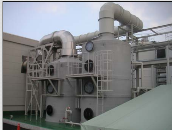
集合タイプ(複数:1) 処理風量:400m 3 /min 用途:PFC除害
