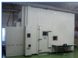
恒温恒湿室外観
