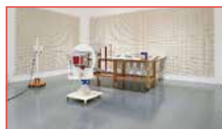
車載電波暗室 6室
